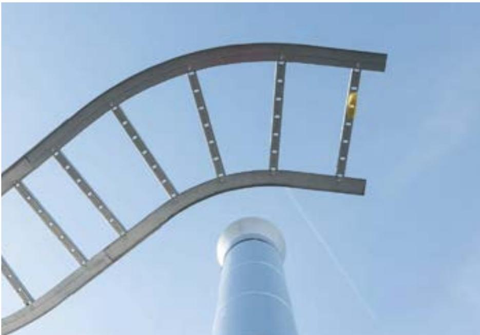
Ein leerer Kabelkanal auf dem Dach des Rechenzentrums. Hier werden die Kühl- und Solaranlagen installiert.
