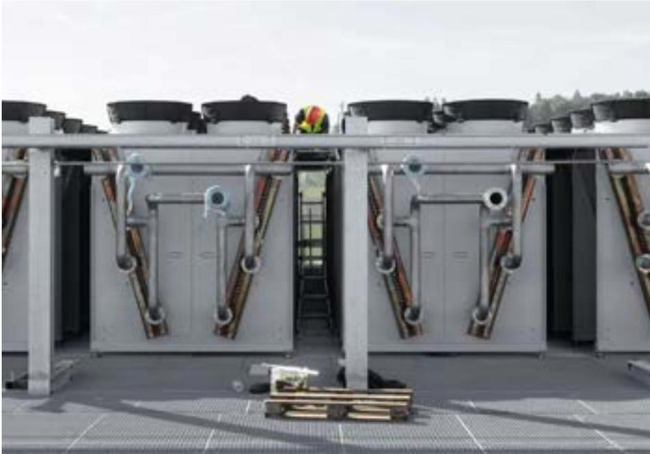
Kühlanlage auf dem Dach des Rechenzentrums: An 300 Tagen im Jahr wird kalte Luft zur natürlichen Kühlung verwendet.
