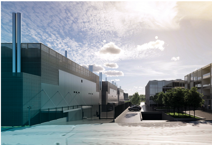
Green erweitert seine Cloud- und Datacenter-Plattform erneut: Im Kanton Zürich entsteht der neue Metro-Campus.
