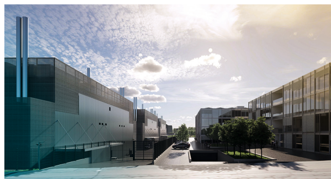
Green erweitert seine Cloud- und Datacenter-Plattform erneut. Im Kanton Zürich entsteht der neue Metro-Campus.
