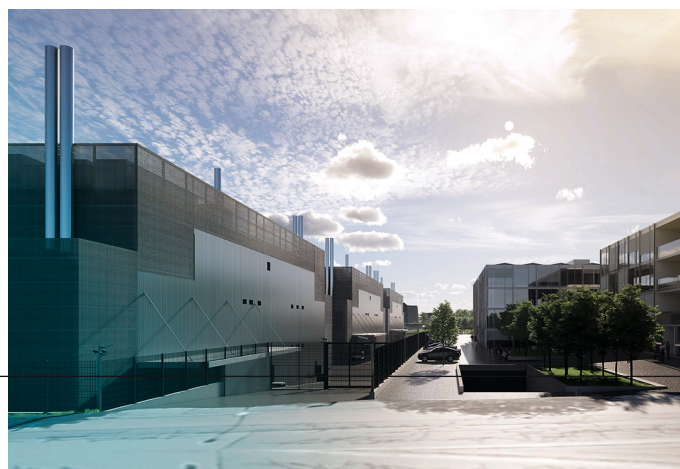
Green erweitert seine Cloud- und Datacenter-Plattform erneut: Im Kanton Zürich entsteht der neue Metro-Campus.
